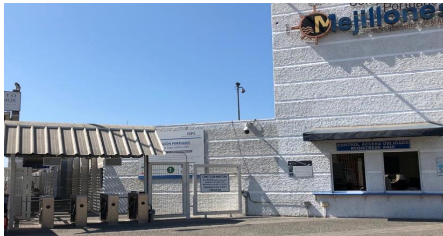
Acceso Principal Puerto Angamos (Torniquetes y Ventanilla)
